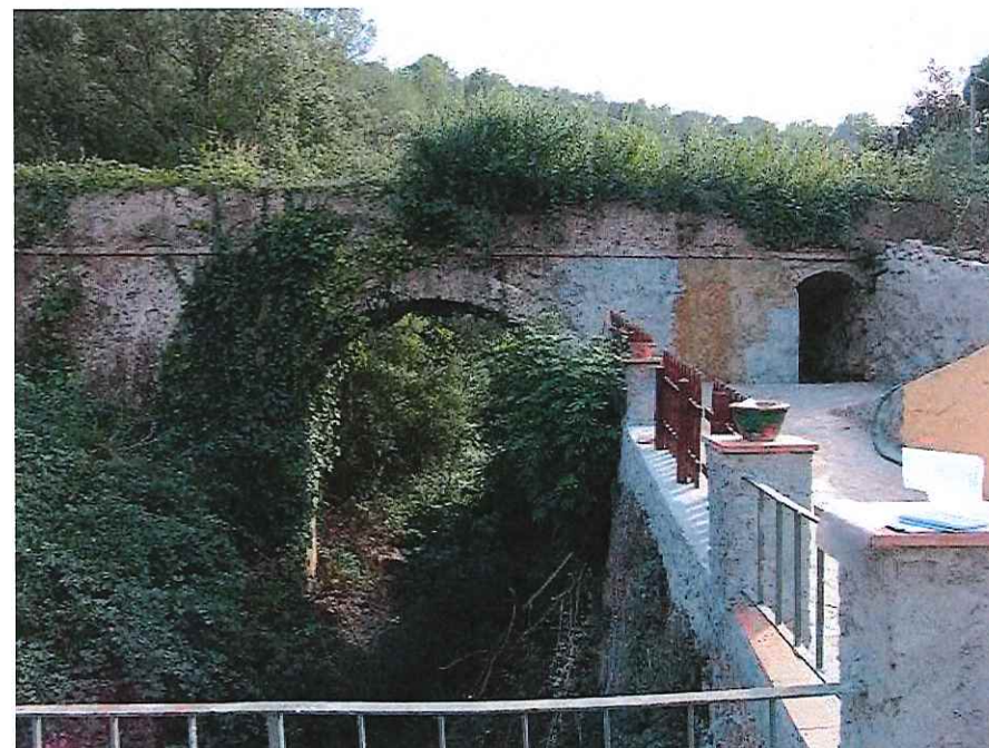
Pas elevat de l'aigua de la sèquia per lliurar el desnivell del Sot del Guix.
